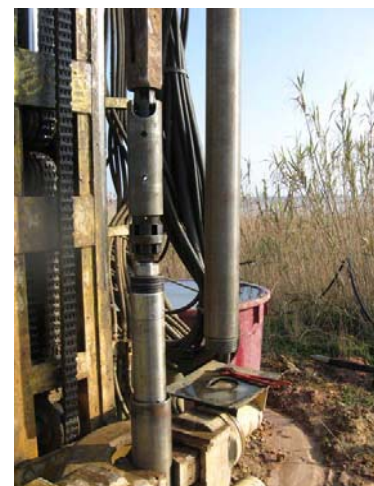
Sondaggi a carotaggio continuo
