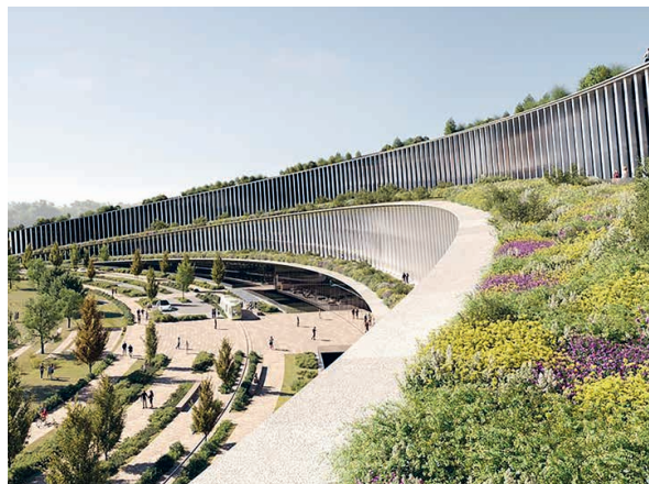
La copertura verde del Nuovo Ospedale di Cremona diventa paesaggio vivo, con terrazze vegetate che si fondono con gli spazi pubblici e favoriscono benessere e continuità con il parco.
