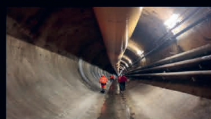
ASSISTENZA AMBIENTALE DI CANTIERE
