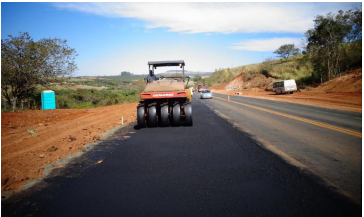
MINAS GERAIS(BRASILE) - INTERVENTI DI AMPLIAMENTO/MIGLIORAMENTO DELLA RODOVIA MG-050 (2012 - 2015)
