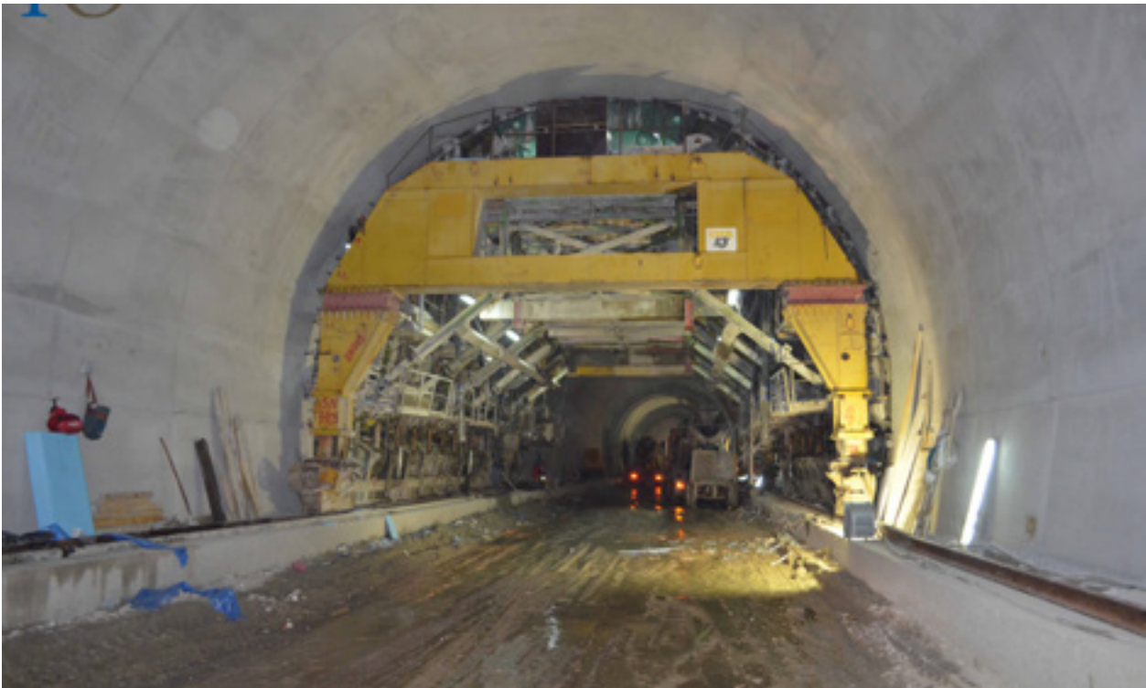
ALBANIA- SUPERVISIONE DEI LAVORI DI COSTRUZIONE DEL TUNNEL KRRABA NEL TRATTO STRADALE TIRANA - ELBASAN
