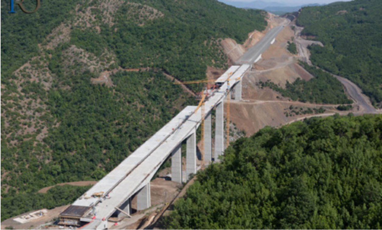
MACEDONIA - SUPERVISIONE DEL TRATTO LUNGO IL CORRIDOIO X DELL'AUTOSTRADA DEMIR KAPIJA - SMOKVICA
