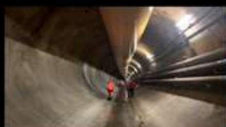
ASSISTENZA AMBIENTALE DI CANTIERE
