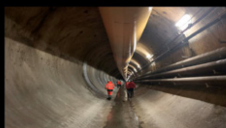
ASSISTENZA AMBIENTALE DI CANTIERE
