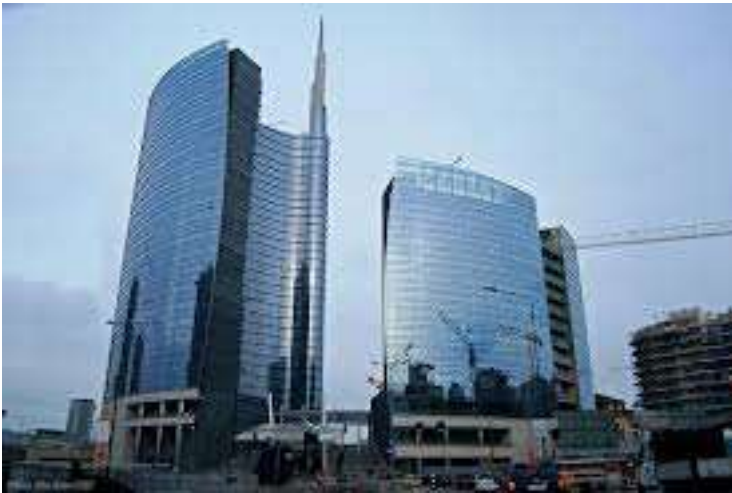
Figura 7 – Immagine del cantiere ed interferenza con Cantiere Via del Sud.
