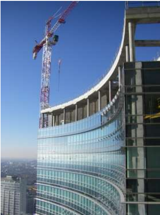
Figure 5- 6 – Immagini del cantiere durante la realizzazione delle facciate.
