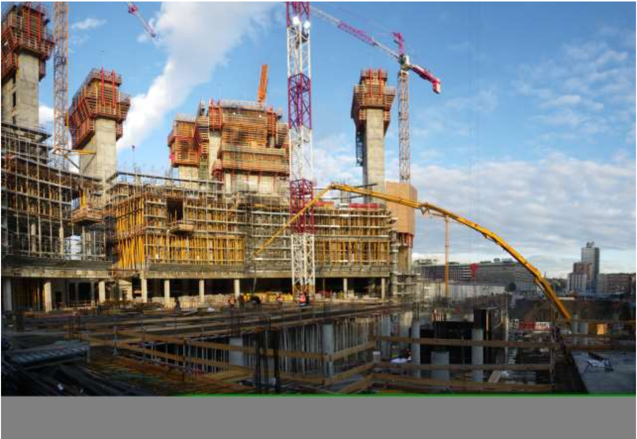
Figura 1 – Immagine del cantiere durante la realizzazione delle strutture in c.a.
