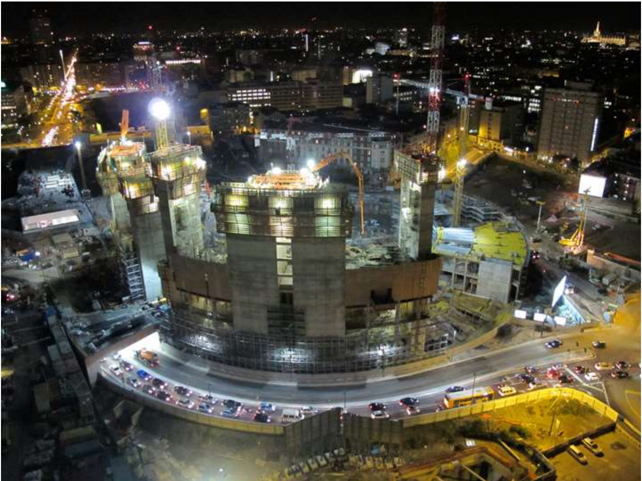
Figura 4 – Immagine del cantiere durante la realizzazione del Complesso PNG – Lavorazioni notturne.
