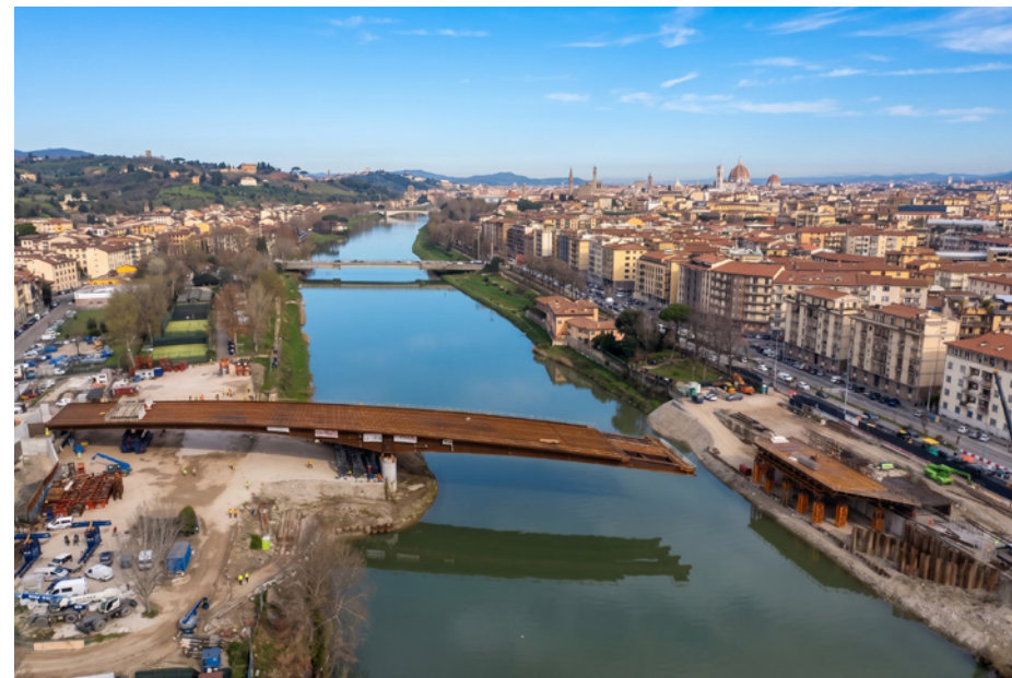
Sistema tranviario Fiorentino. Lotto 2 VACS e Linee 3.2. Nuovo ponte sul fiume Arno
