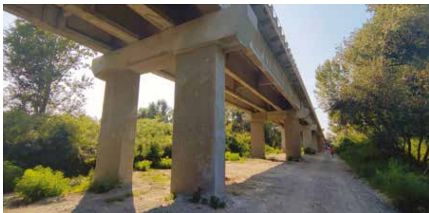
2. Un tratto di ponte in territorio reggiano, golena destra
