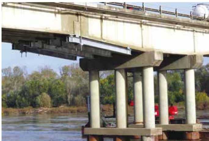
6. L'intervento di messa in sicurezza delle selle Gerber (1° Lotto di intervento)
