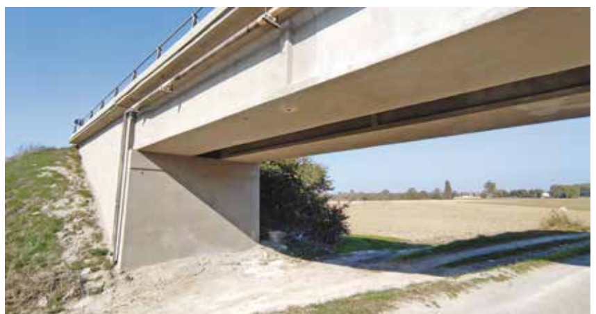
5. Una foto post-operam del risanamento corticale della campata 1, spalla sinistra (1° Lotto di intervento)
