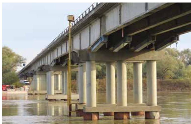
1. Un tratto di ponte in territorio mantovano, alveo di magra e golena sinistra
